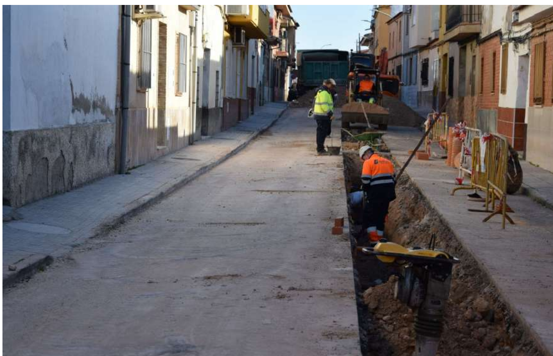
Obras de renovación de tuberías en la calle Primavera de Daimiel / Lanza
