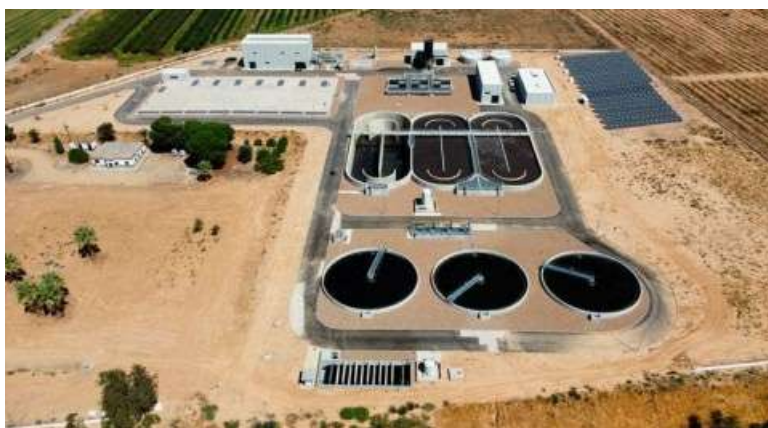
EDAR de Montijo-Puebla de la Calzada
