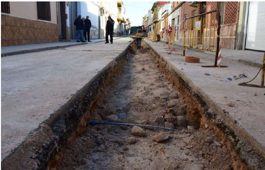
Comienza la renovación del saneamiento de la calle Primavera
