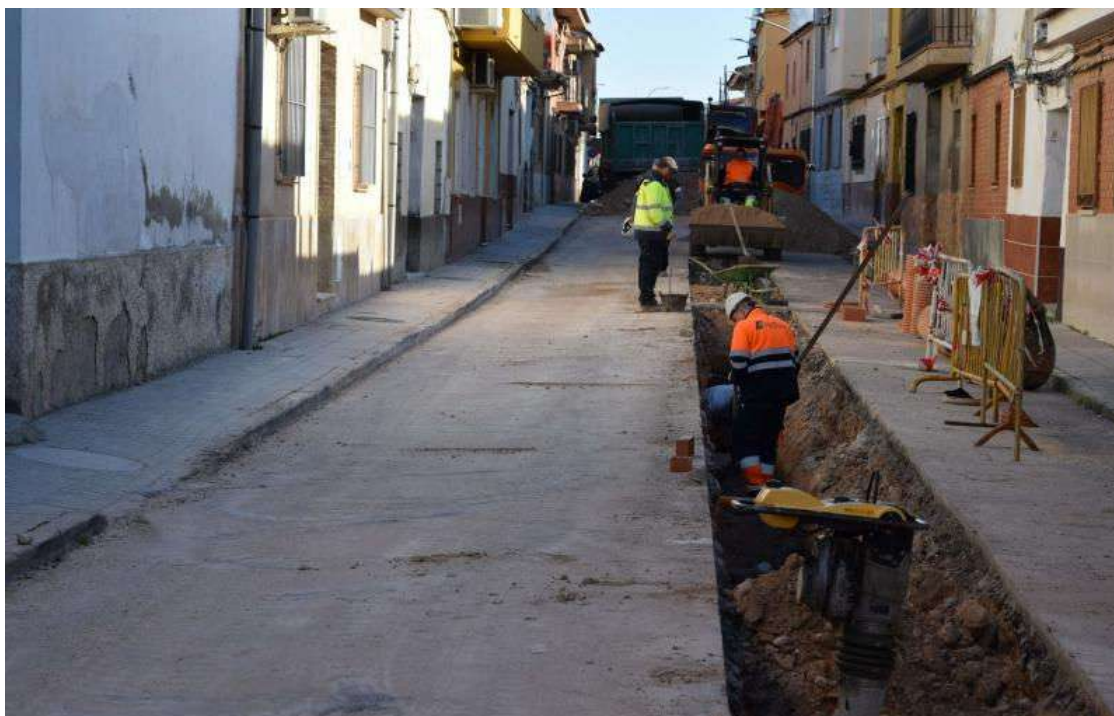
El tramo de tubería que se va a sustituir mide 100 metros.
