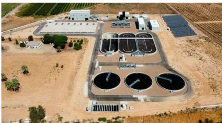
EDAR de Montijo-Puebla de la Calzada
